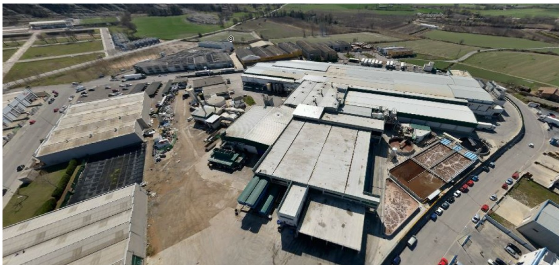
Vista aèria de l'escorxador Le Porc Gourmet de Santa Eugènia de Berga | Grupo Jorge
