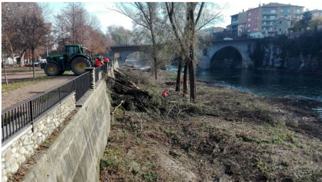
Treballs de tala dels arbres, aquest dimecres a toca del passeig del Ter de Manlleu Foto: Grup de Defensa del Ter
