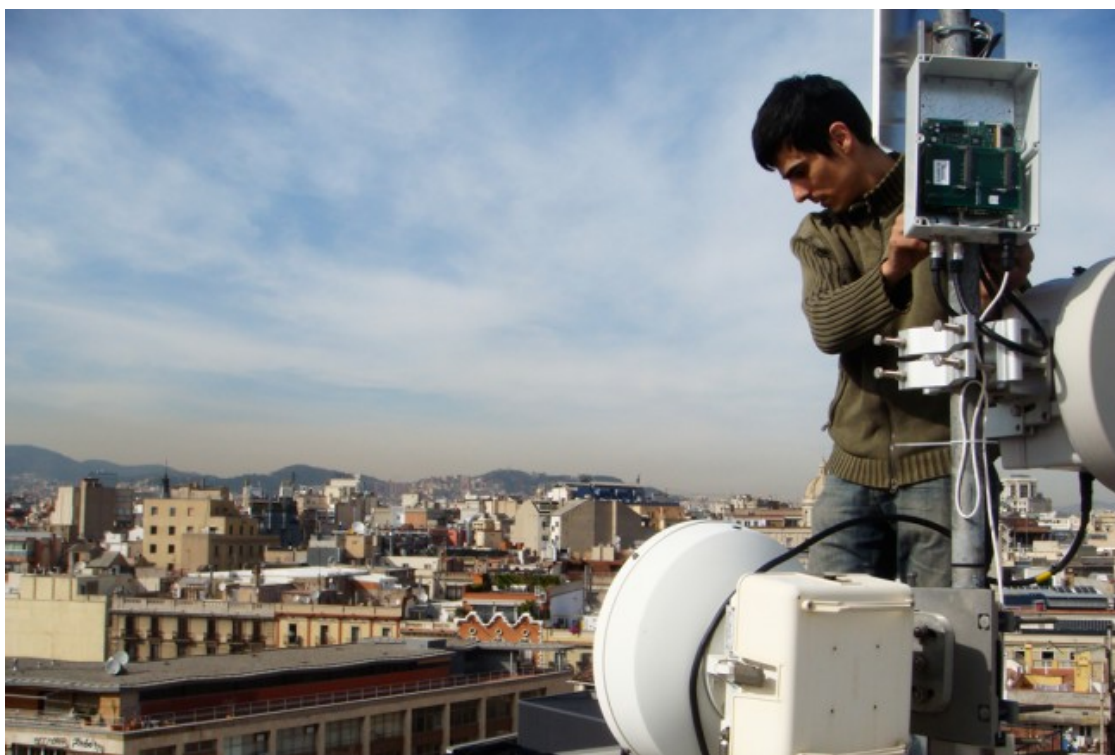
Instal·lació d'un node de la xarxa de telecomunicacions autogestionada de guifi.net Foto: guifi.net
