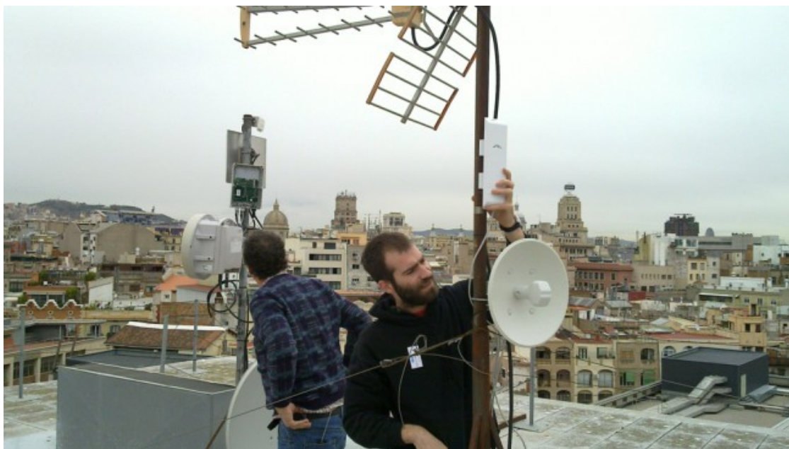
Instal·lació d'una antena de la xarxa de telecomunicacions autogestionada de guifi.net Foto: guifi.net
