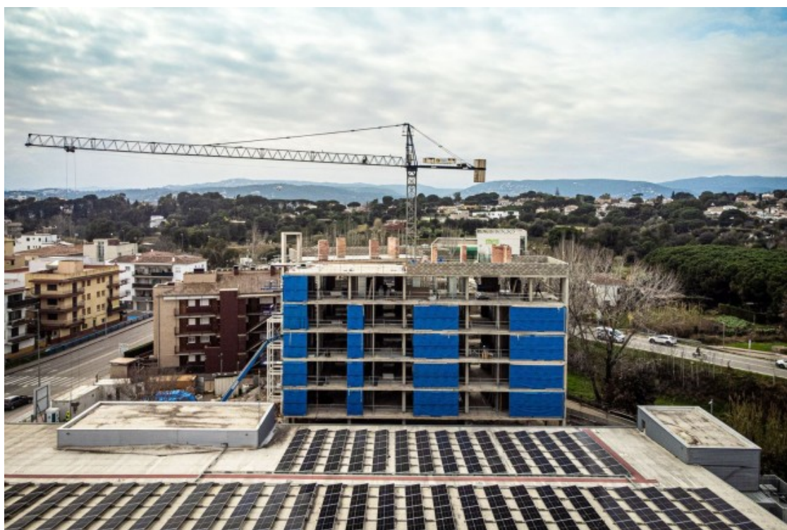
L'edifici de Terra de Mar, a Palamós, ja construint-se
