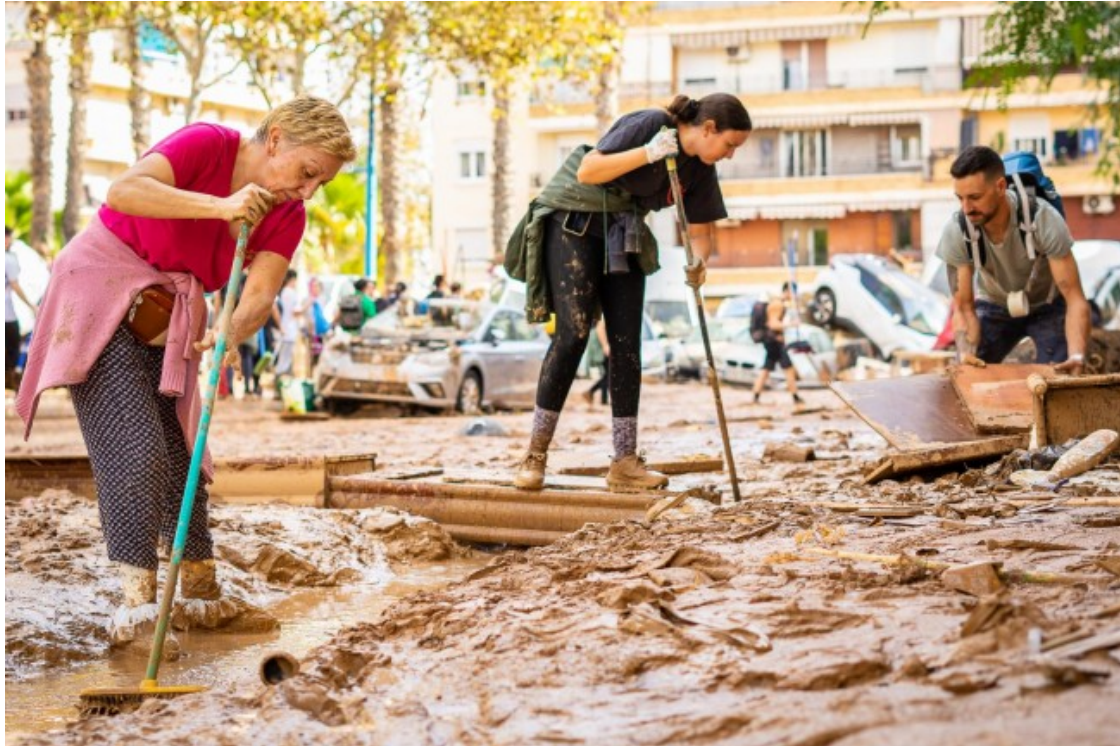
Voluntàries retiren fang per facilitar els accessos als carrers i habitatges del barri Parc Alcosa. Foto: Ona Cano
