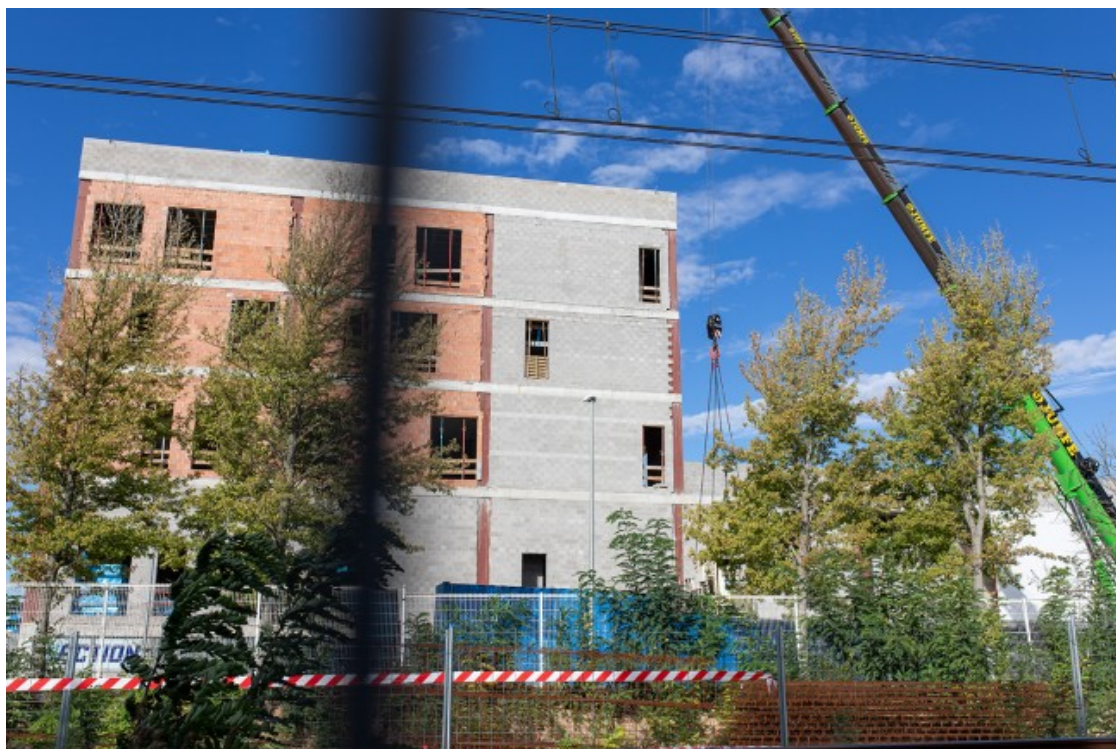
Edifici en construcció a Vic Foto: Sara Blázquez Castells
