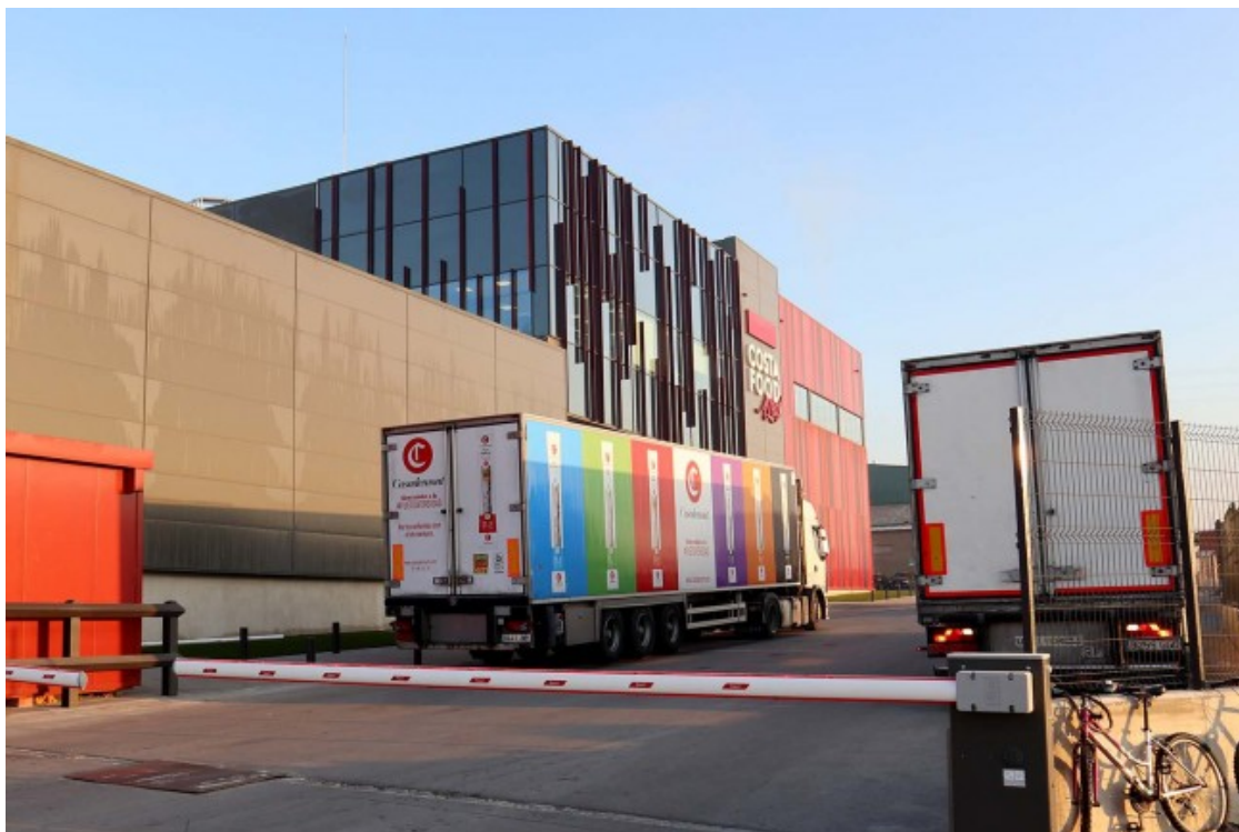
Instal·lacions de Costa Food a l'illa càrnia de Vic Foto: Josep Comajoan
